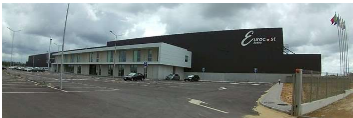
Figura 120 – Edifício da Eurocast, visto de NO.
