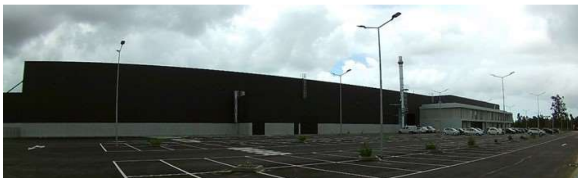
Figura 123 – Edifício da Eurocast, visto de Norte – estacionamento.
