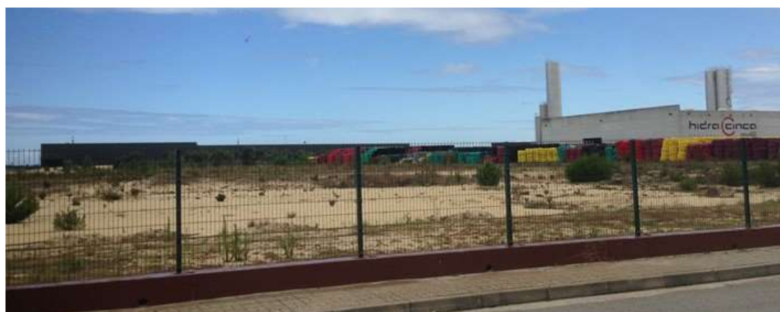
Figura 125 – Edifício da Eurocast, visto de Sul.
