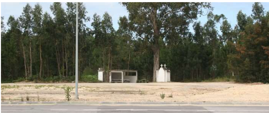
Figura 126 – Capela do Sr. do Desterro - enquadramento (vista de Norte).
