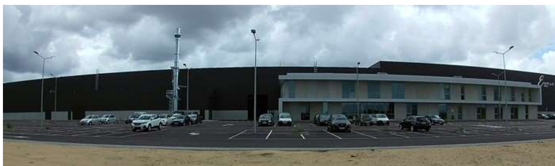
Figura 122 – Edifício da Eurocast, visto de Norte.
