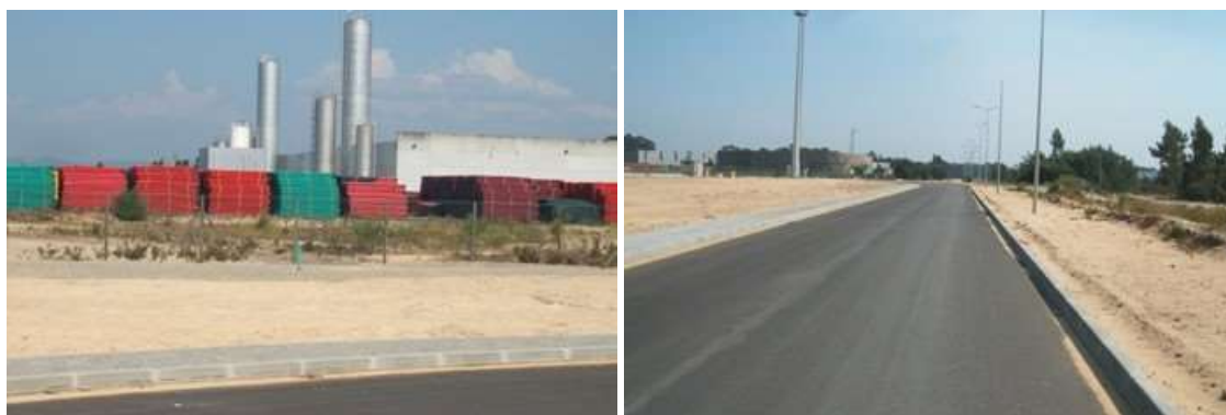
Figura 189 – Unidade industrial próxima da zona de intervenção (esq) e via de acesso ao Eco-Parque Empresarial (dta)
