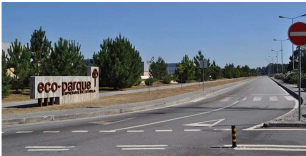
Figura 167 – Registos fotográficos das vias de circulação interna do Eco-Parque Empresarial de Estarreja.
