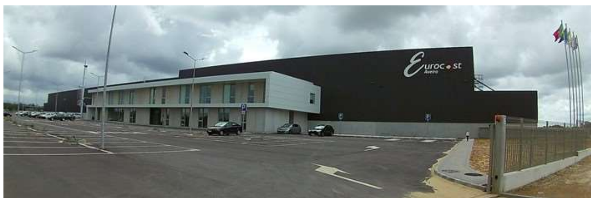
Figura 88 – Unidade industrial da Eurocast Aveiro, S.A..
